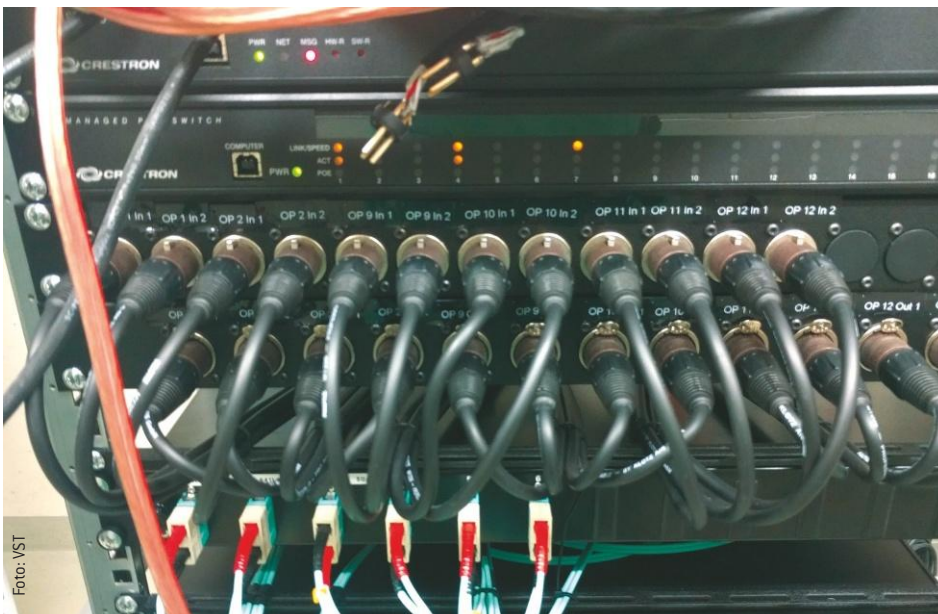
Es ist vorgesehen, zwei Videosignale aus jedem OP in einen Technikraum zu führen und in umgekehrter Richtung auch zwei Videosignale in den OP-Saal auszuspielen zu können.
